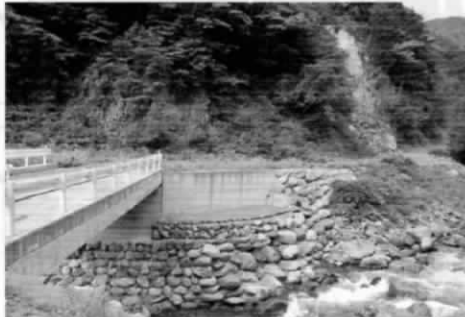
二軒小屋より1時間30分歩いた燕沢上流に、鉄筋コンクリートの立派な橋。この奥に作業員宿舎建設予定地
