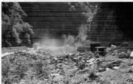
中部電力 二軒小屋より 500メートル上流の場所
