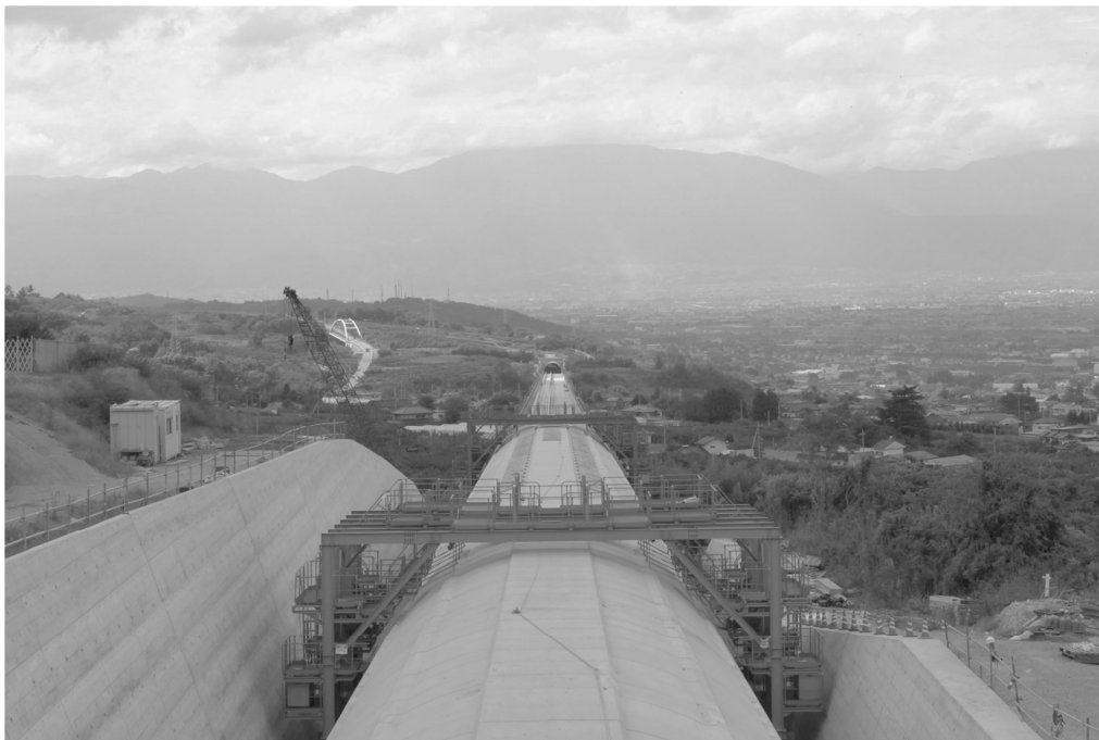
延伸工事中の山梨リニア実験線。後方は南アルプス前衛、楡形山
