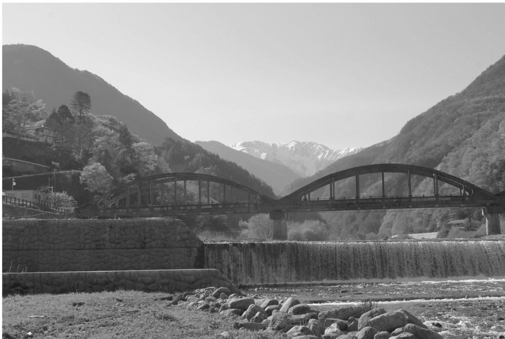
小渋川から望む赤石岳。 右手の斜面に沿って鉄塔（村内9基）と送電線が上蔵の変電施設にのびる
