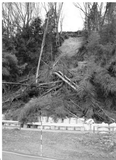
年末に土砂崩れを起こしたヘルシーミート手前の道。リニアは災害を回避できない
